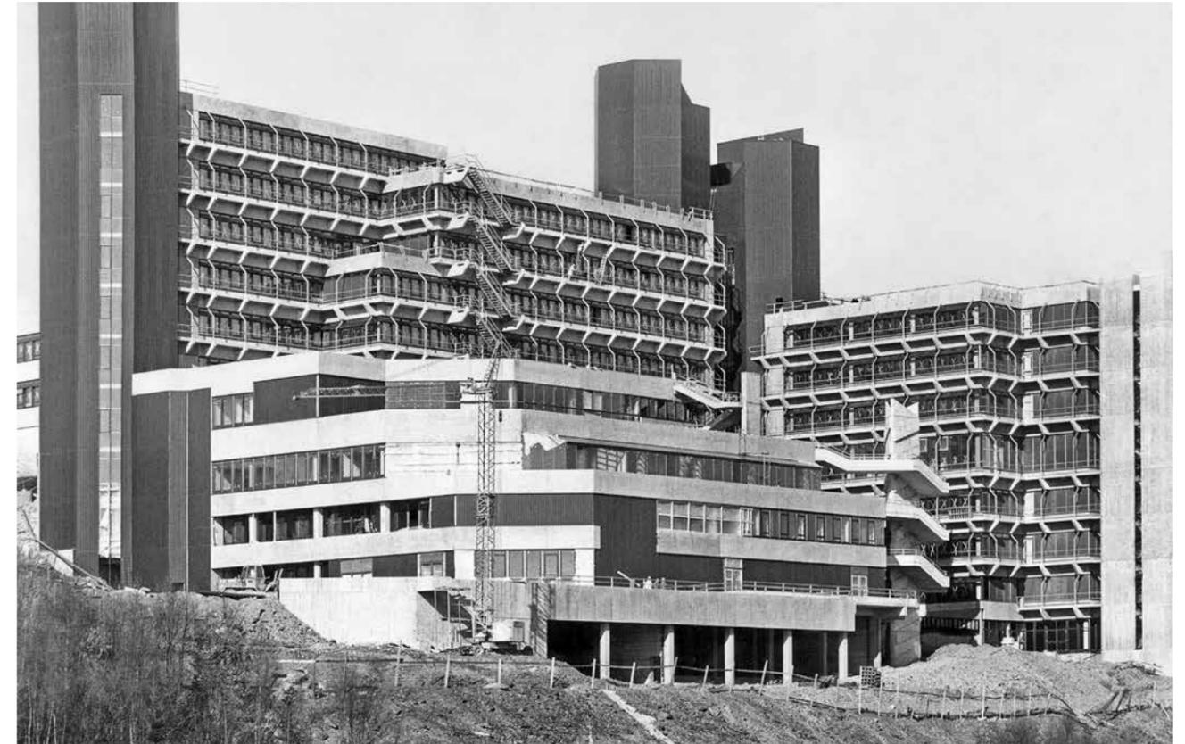
Die Technik bestimmt die Optik: Das Bauen mit Betonfertigteilen ermöglicht es, preiswert und schnell zu bauen. Es gibt „Gebäude von der Stange“. Die Folge: Die fünf neuen Gesamthochschulen in NRW sind alle nach demselben Bauprinzip gestaltet. Materialien, Bauweisen und Anordnungen prägen die Ähnlichkeit im Erscheinungsbild. Die landschaftliche Einpassung allerdings führt zu individuellen Lösungen.
